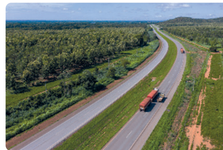
Rodovia no município de Rosário Oeste, MT, em 2021.
