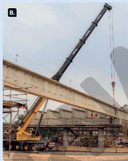
Construção de viaduto no município de Limeira, SP, em 2021.
