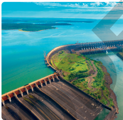
Na foto, de 2021, observamos a usina concluída. As últimas unidades geradoras foram inauguradas em maio de 2007.
