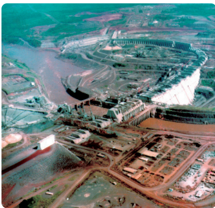
Paisagem na fase de obras civis da barragem principal no leito do rio Paraná, em 1980.
