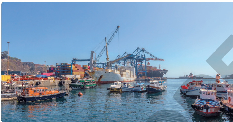
Porto localizado na cidade de Valparaíso, Chile, em 2020.
