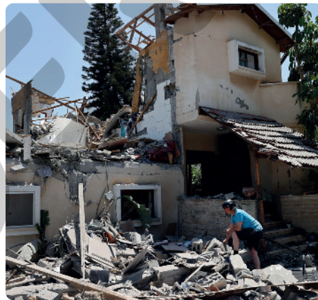
Escombros de um edifício destruído por bombas lançadas por palestinos na cidade de Yehud, Israel, em 2021.
