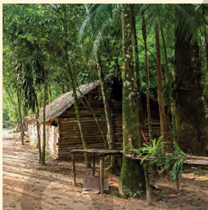
Na Terra Indígena Rio Silveira, em Bertioga, as moradias são construídas tradicionalmente de pau a pique ou madeira. São Paulo, 2021.
