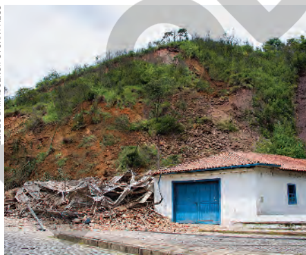
Desmoronamento do Morro da Forca, em Ouro Preto (MG), ocorrido no dia 13 de janeiro de 2022.
