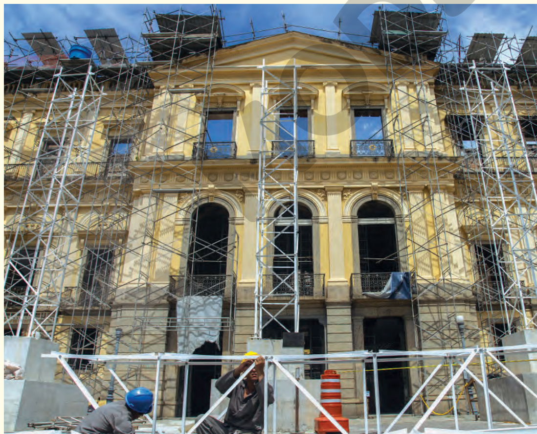
Obra de restauração do Museu Nacional, vinculado à Universidade Federal do Rio de Janeiro (UFRJ), no Rio de Janeiro (RJ), que foi atingido por um incêndio em 2018. Foto de 2019. O Museu Nacional é o mais antigo do Brasil e abriga um importante acervo nas áreas de história, antropologia e ciências naturais, além de formar pesquisadores.
