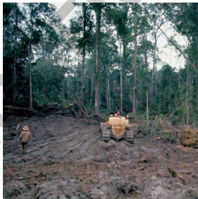
Derrubada de floresta para a construção da Rodovia Transamazônica (BR-230), no Amazonas. Foto da década de 1970.
